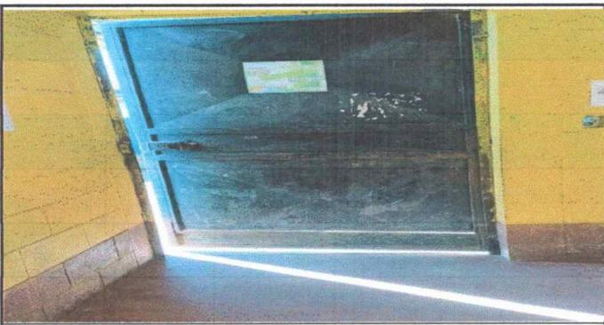
Foto 5: En esta fotografía se observa el mal estado de la puerta de un módulo que necesita ser sustituida por una nueva.
