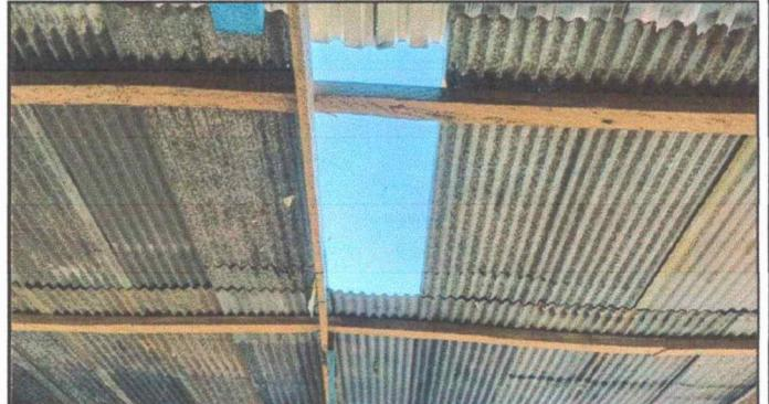
Foto 4: En esta fotografía se logra observar el mal estado del entechado de un módulo, es necesario sustituirla por láminas troqueladas.
