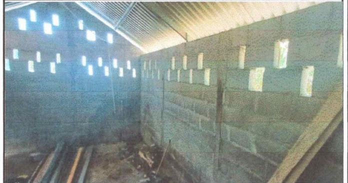
Foto 2: En esta fotografía se logra observar el mal estado de la pared de la cocina, se necesita repellar.
